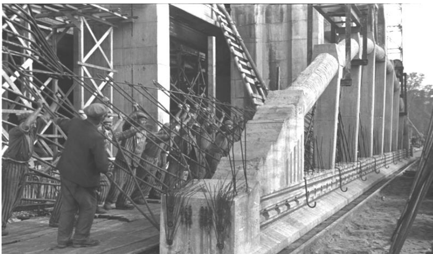
113. Więźniowie obozu pracy przymusowej w Bremen podczas budowy bunkra łodzi podwodnych w 1944
