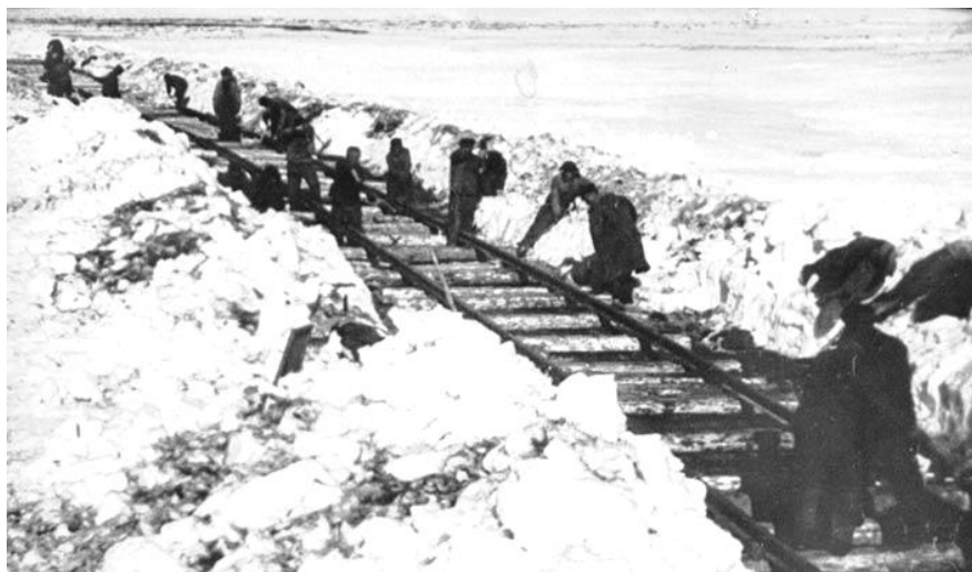
364. Workuta. Więźniowie obozu (łagru) budują linię kolejowa. 1940
